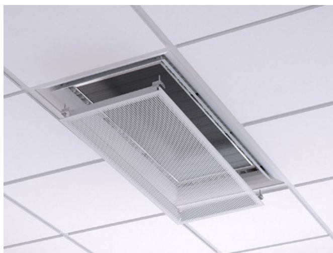
Abb. 17. Demontage der Unterseite zum Freilegen des Registers
