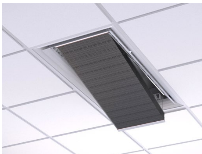
Abb. 18. Demontage der Unterseite und Herabklappen des Registers für eine gründliche Reinigung bei hohen Hygieneanforderungen.
