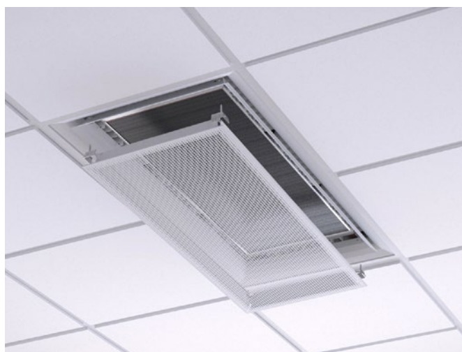
Figure 12. Dépose de la face avant pour accéder à la batterie
