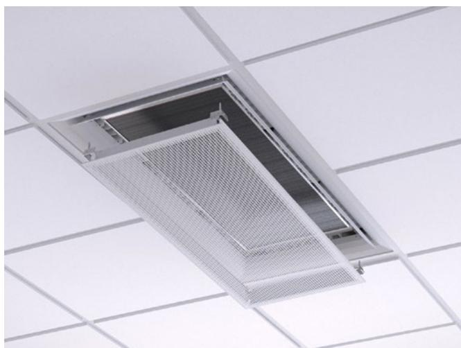
Figure 15. Dépose de la sous-face pour accéder à la batterie
