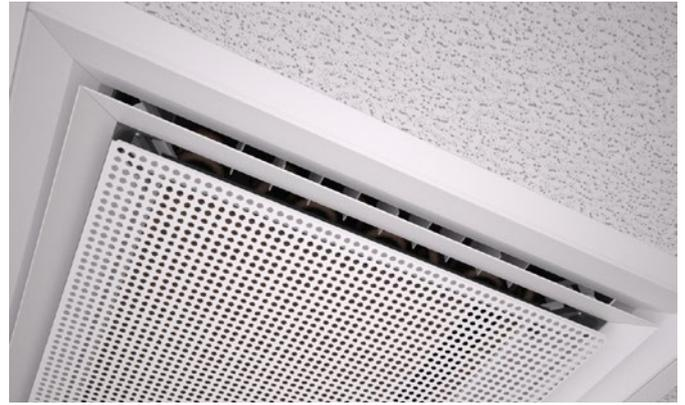
Figure 11. Sous-face standard – Perforations circulaires disposées en carré
