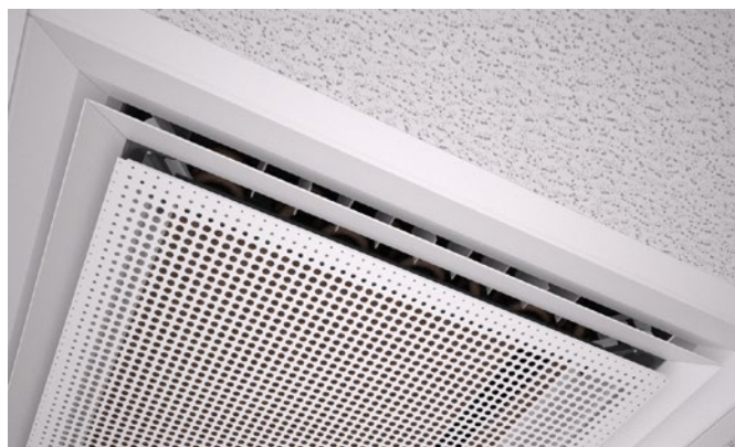
Figura 12. Fori circolari della piastra anteriore PD disposti in uno schema quadrato con bordo graduato
