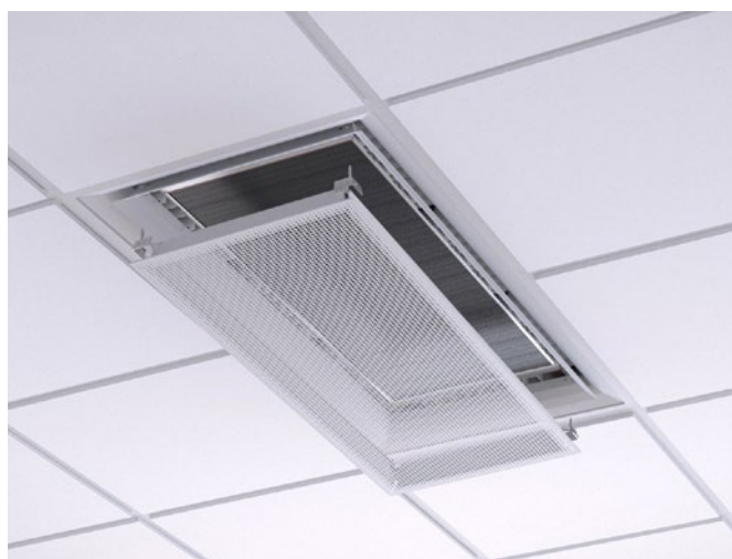
Figura 15. Rimozione della piastra anteriore per accedere alla batteria
