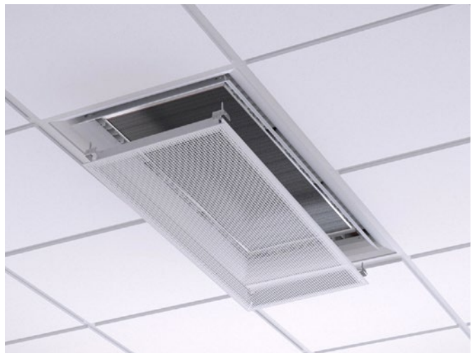
Abb. 15. Demontage der Unterseite zum Freilegen des Registers
