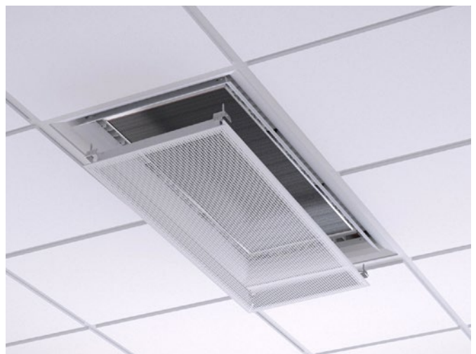
Abb. 12. Demontage der Unterseite zum Freilegen des Registers
