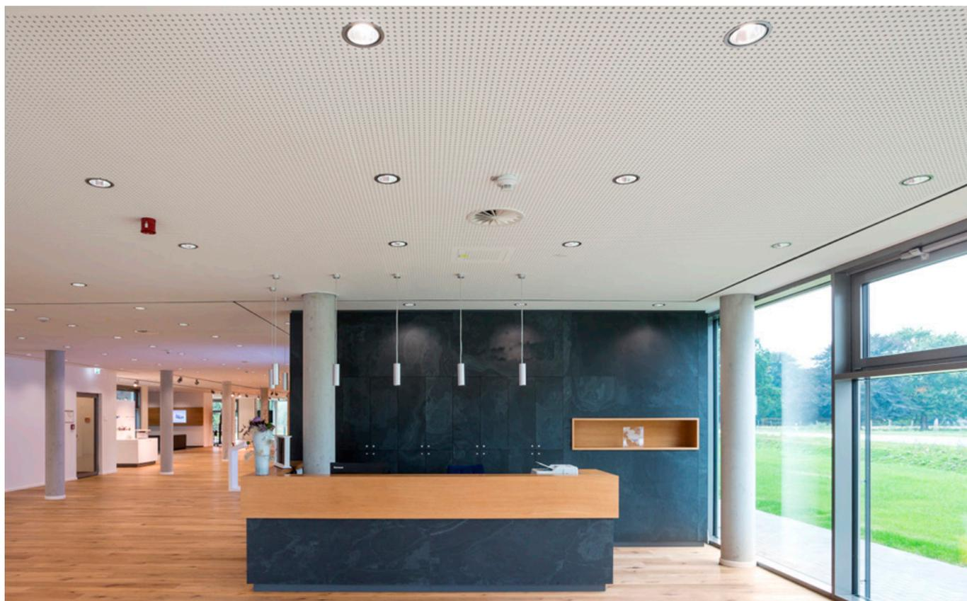
Fig. 7: Soffitto radiante con cartongesso forato e vari apparecchi (luci, aria, sprinkler, rilevatori di fumo)
