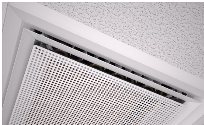
Abb. 10. Standardmäßiges Unterblech. Runde Löcher in quadratischem Muster
