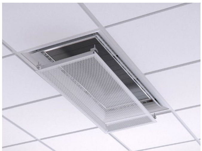
Abb. 14. Demontage des Unterblechs zum Freilegen des Registers
