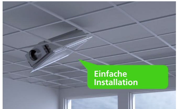
Abb. 13. Installation in vorhandenem T-Profil
